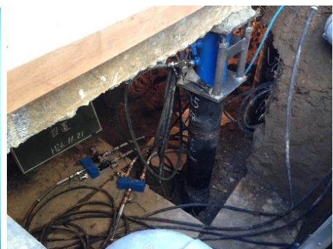
住宅の沈下修正工事！ 補修費用約450万円かかりました
